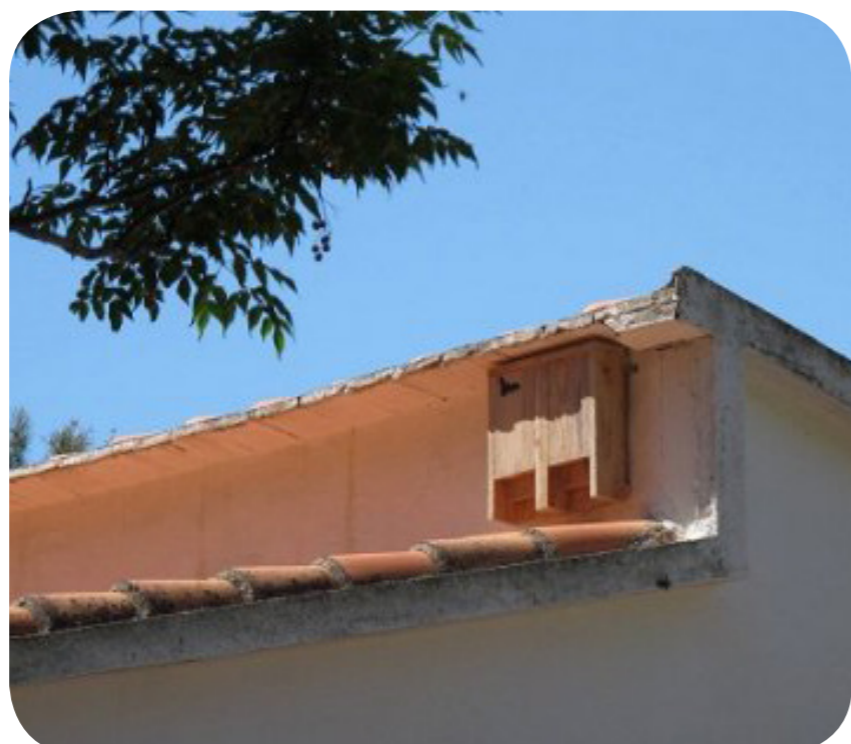
INSTAL·LACIÓ CAIXES RATES PENADES
